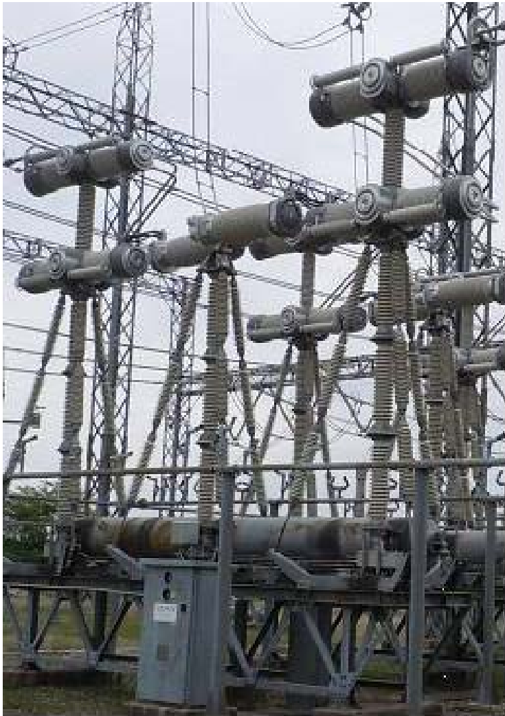
275kV air blast breaker (ABB)
